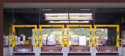
Portiques en porte à quai sur site DHL
